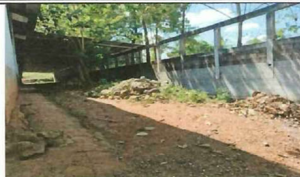
Foto 2: En esta parte se ve la necesidad de continuar con el techo y así aprovechar ambas paredes para la cocina
